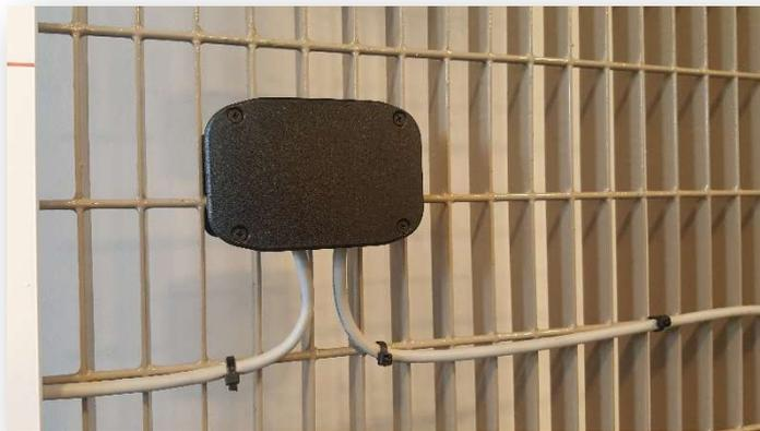
3. Une fois les réglages et programmations effectués fermer le dispositif en veillant à ce que le joint d'étanchéité soit correctement placé.
