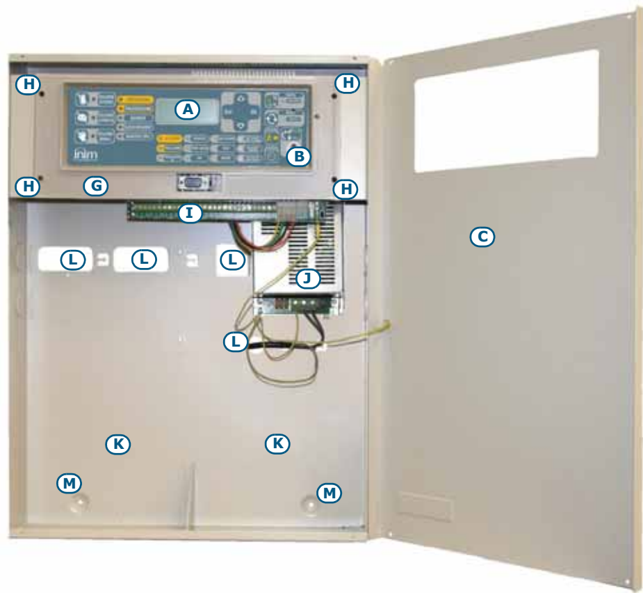
Figure 5 - Intérieur de la SmartLine036
