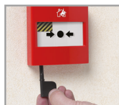
3: Une simple clé permet de réinitialiser le poste d'alarme.
