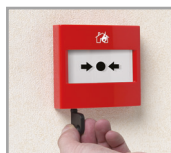
4: Il suffit de tourner la clé pour réinitialiser le poste.
